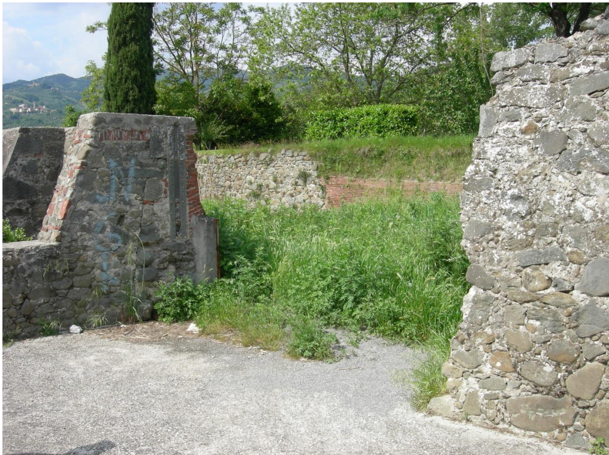
FIGURA 4. APERTURA NEL MURO DI SPONDA DESTRA DEL T. BORRA PRESSO LA SEZIONE 35.1
